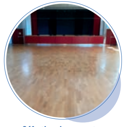
Réfection du parquet de la salle des fêtes
